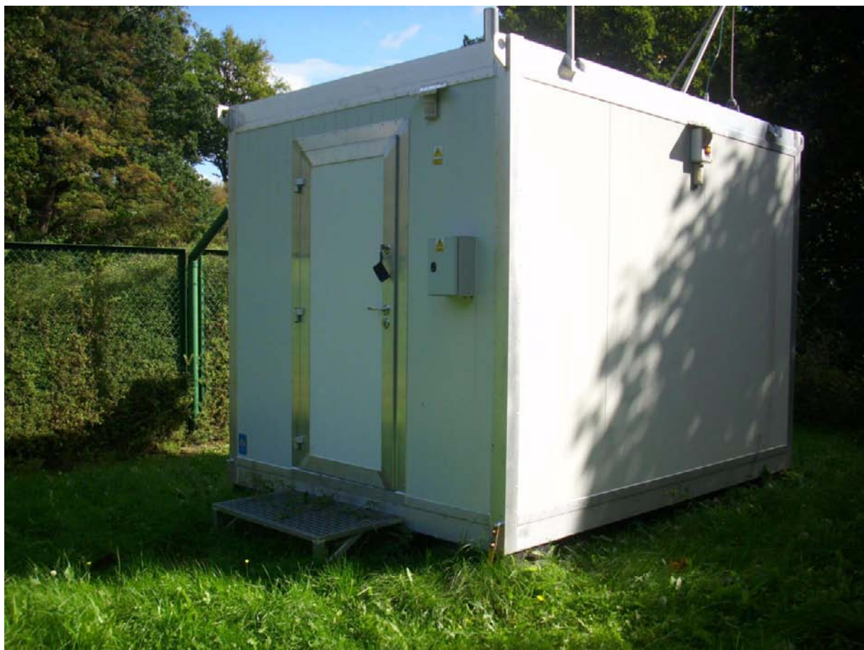
Ryc. 1 Nowy kontener na stacji AM1 Gdańsk Śródmieście
